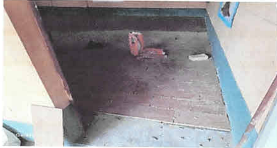
Suministro e instalacion de canales
