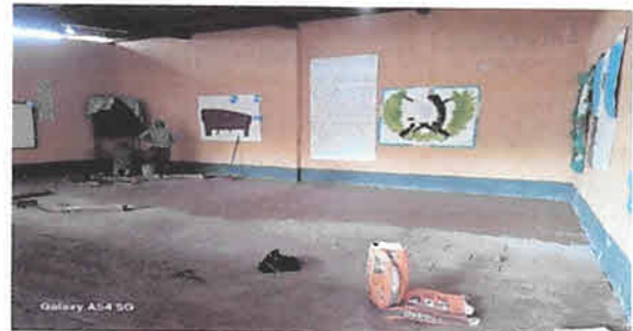
Sustitucion de piso torta lisa por piso ceramico en aulas
